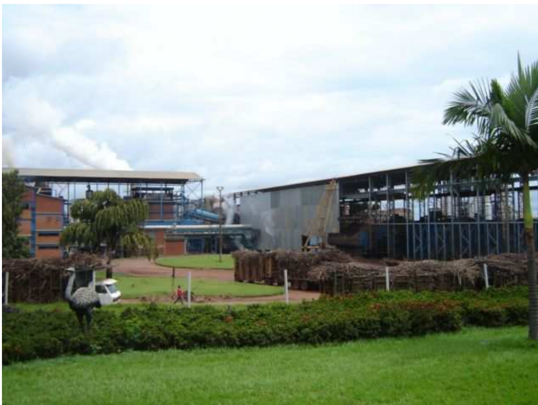
Foto 1 – Vista geral da usina
